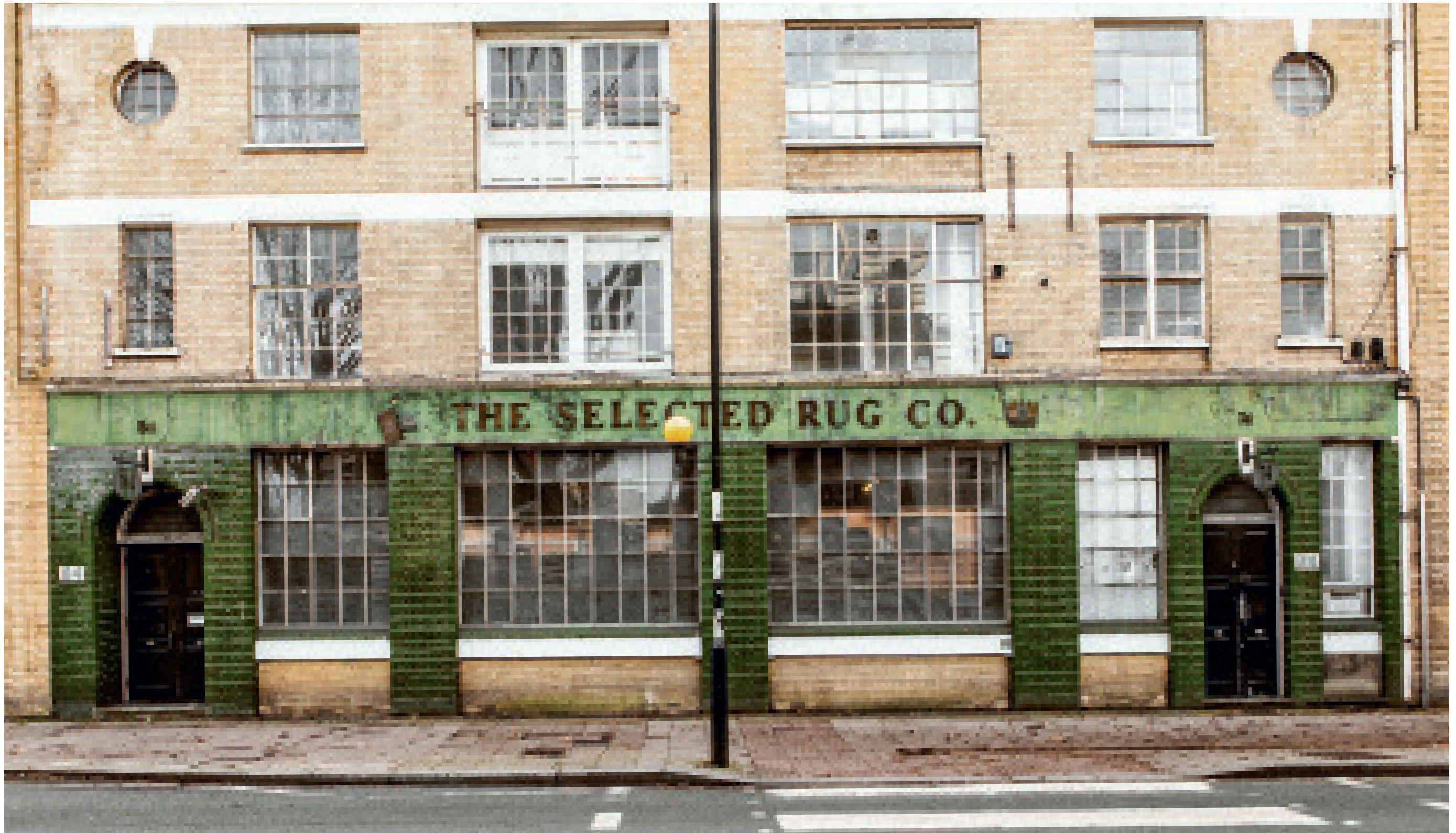
Het industriële verleden van Bermondsey is nog steeds op elke hoek zichtbaar. Verweerde winkelpuien, zoals deze groen betegelde in Long Lane, bewijzen dat.
