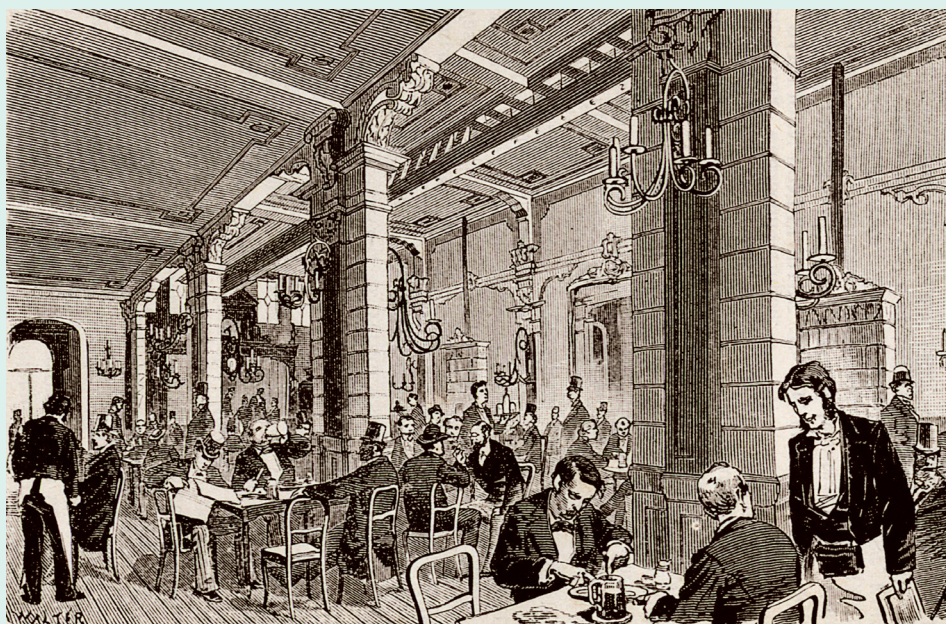
[5.5] Aan de biefstuk in de grote eetzaal van Die Port van Cleve, rond 1882.
